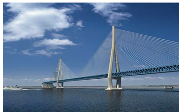
📍 世界上在建的最大跨径的公铁两用斜拉桥——沪通长江大桥
