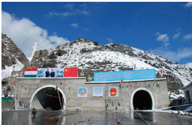
沙赫里斯坦隧道位于塔乌公路杜尚别至塔什克段。
